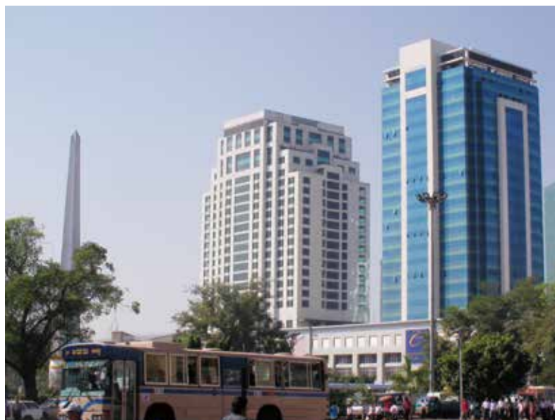
ミャンマーは現在、様々な外資系企業の進出が目立ってきている。今後もその勢いが増すのは確実であり、特に生産技術を持った外資系企業・工場誘致への期待感が大きい。
